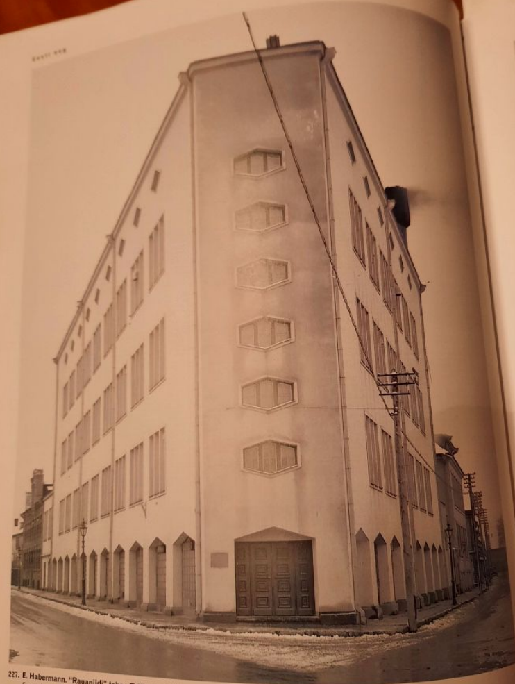
227. E. Habermann. "Rauaniidi" tehase Tallinnas Põhja püesteele, 1926–32. Valmimisjärgne foto Eugen Habermann. Rauaniidi Textile Mill in Põhja Blvd., Tallinn, 1926–32. Post-construction photo
